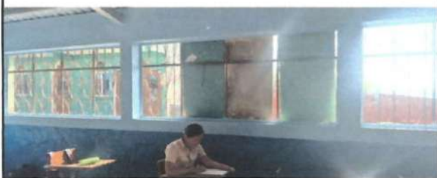
Foto1: Sustitución de ventanas; sistema de apertura: Corredizas, Perfiles color blanco estandar, Material del marco: PVC Material de la ventana: Vidrio, sellado perimetral.
