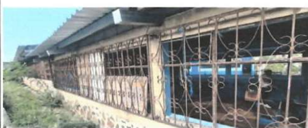
Foto 2: Reparación o sustitución de barandales metálicos, incluyendo fijaciones, pintura y soldaduras.
